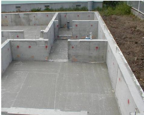
鉄筋コンクリート布基礎外断熱工法を標準としています。基礎幅は上部については15cm、ベース部分については45cmとなります。
